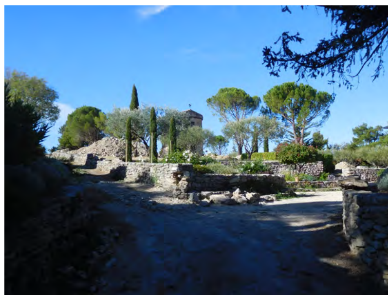
Vue depuis le nord
