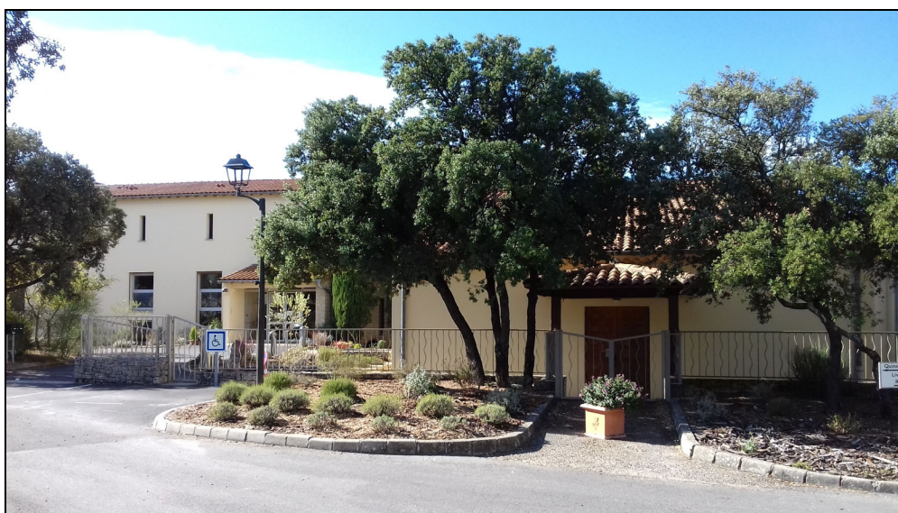
La résidence Autonomie de Quinsan au sud du chemin des Aires
